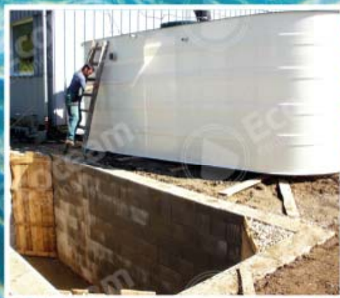
Монтаж на биологична пречиствателна станция АТ100
