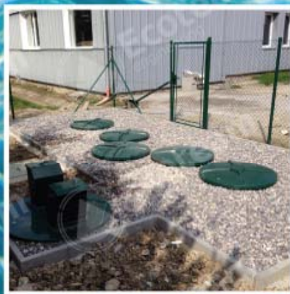
Монтаж на биологична пречиствателна станция АТ100
